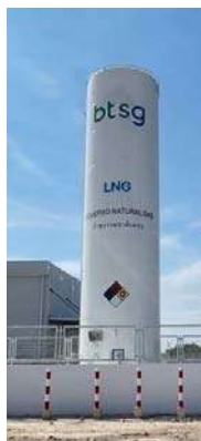
LNG STORAGE TANK
